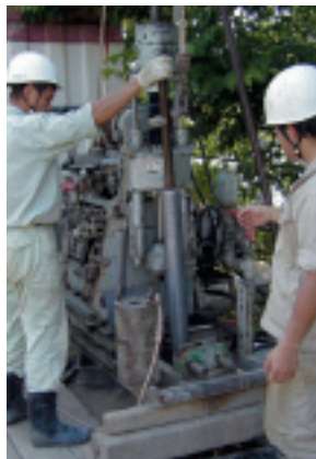
土壌環境調査ボーリング
